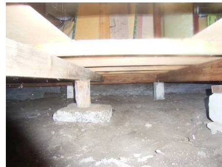
改修前の基礎部分
